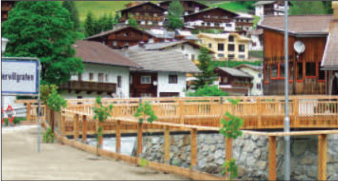
Abschluss des Hochwasserschutzprojektes
