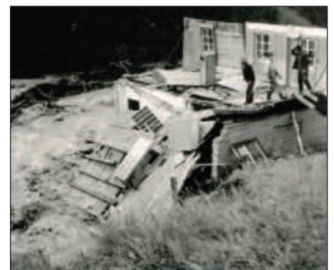
Zerstörtes Haus des Anton Schett
