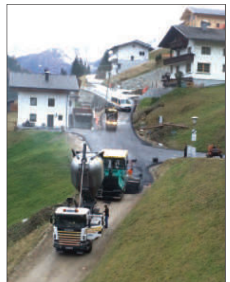
Asphaltierung der Unterwelderstraße
