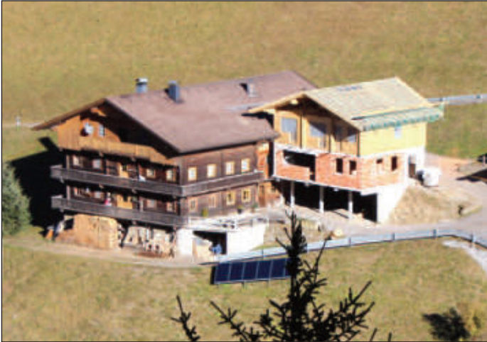
Neubau eines Wohnhauses Pius Schaller, HNr. 57
