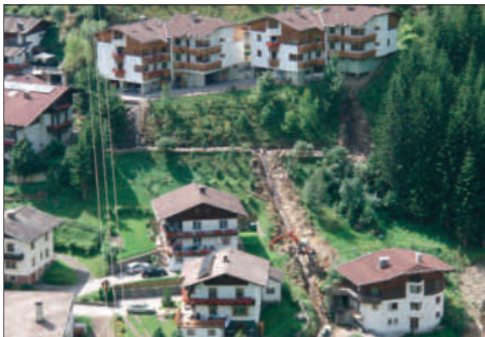
Dorfwärme wird errichtet
