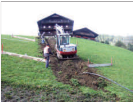
Grabungsarbeiten für den Lichtwellenleiter, im Bild Niederegg und Föstl
