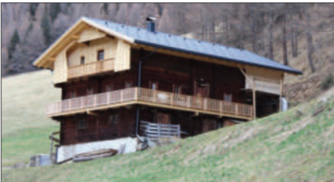
Dacherneuerung und Zubau zur Almhütte Johann Leiter, HNr. 62
