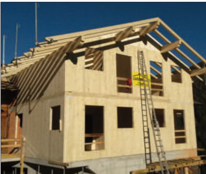
Stallerweiterung im Erdgeschoss, Zubau einer Wohnung im Obergeschoss und Dachgeschoss Johannes Duracher, HNr. 8
