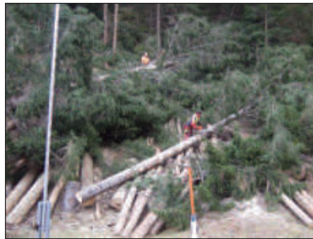
Holzschlägerungen am künftigen Standort des Krafthauses
