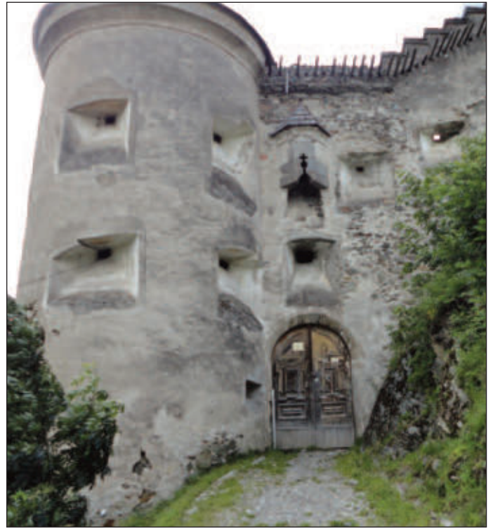
Beteiligung an Burgsanierung Heinfels
