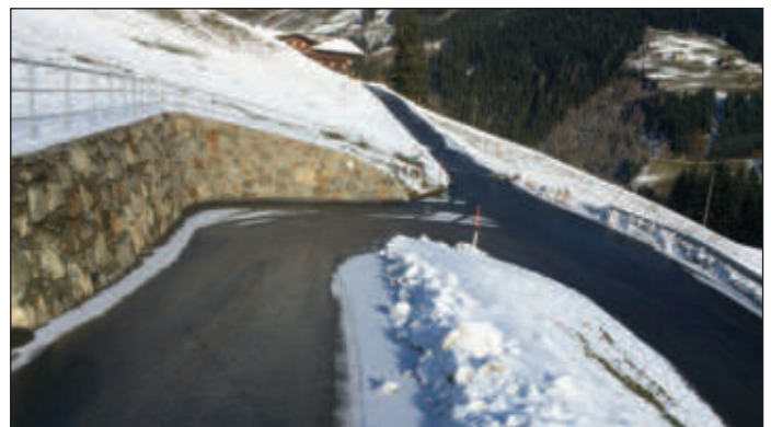
Straße Hinterunterwalden saniert
