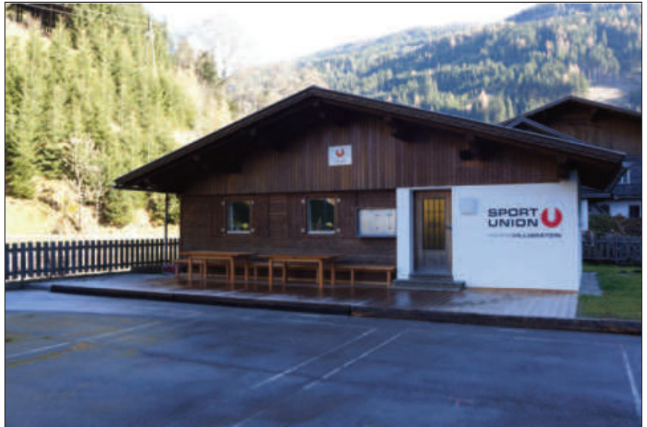
Das neu sanierte Vereinsheim in Außervillgraten
