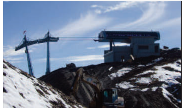
Bau eines 6-er Liftes am Thurntaler
