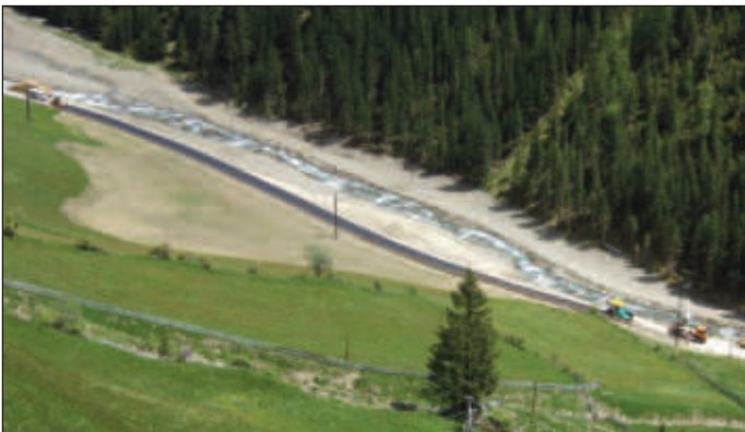
Sanierung Tilliachbach nach Mure
