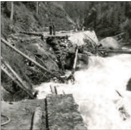
Eine der vielen Straßenunterbrechungen
