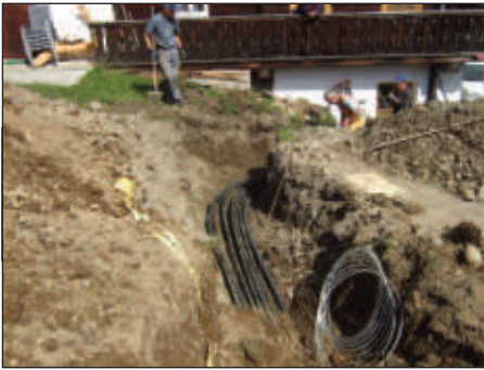
Lichtwellenleiter Leerverrohrung
