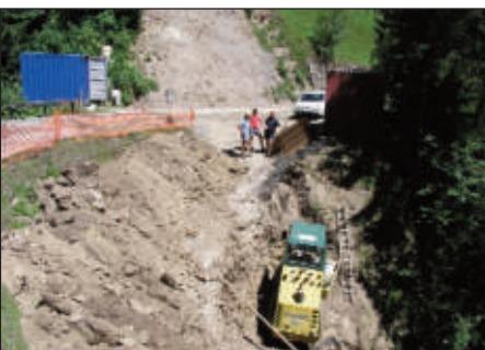
Straßensanierung in Unterwalden
