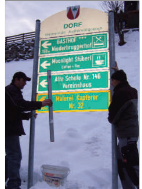
Ortsbeschilderung wird montiert
