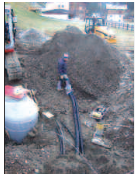
Kanalanschlussarbeiten im neuen Siedlungsgebiet Walchboden
