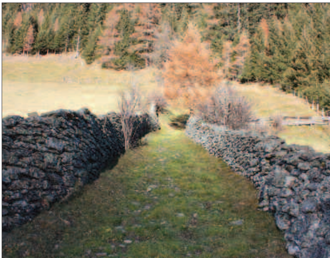
Natursteinmauer oberhalb den Obheimaten in Unterfelden
