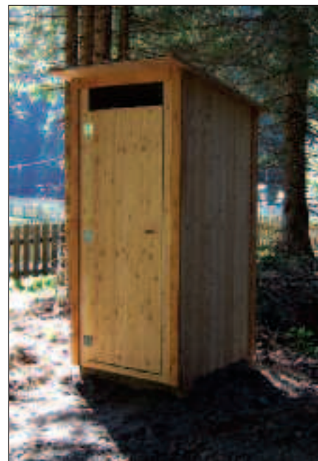
Im Kinderspielplatz wurde ein Abort errichtet
