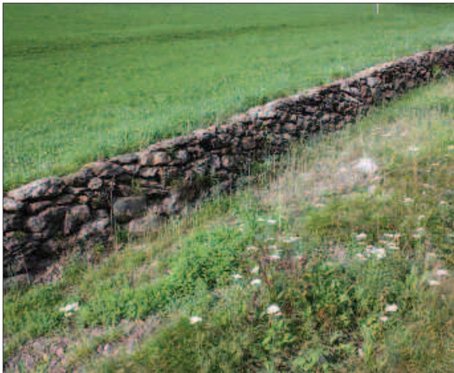
Neu renovierte und teils neu errichtetes Mauerwerk zu Renner
