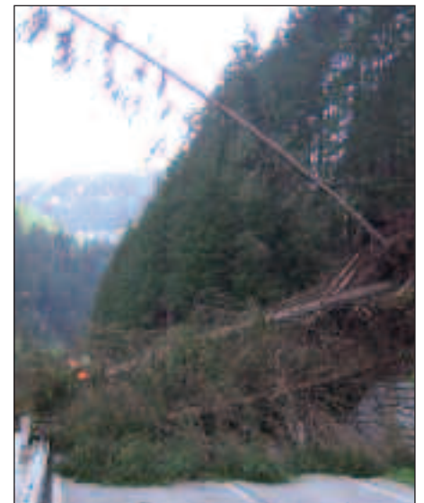
Ein Hangrutsch versperrt mehrere Tage die Villgrater Landesstraße Fotos: Gemeinde
