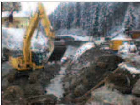
Verbauung Winkeltalbach und Zusammenfluss mit Villgraterbach
