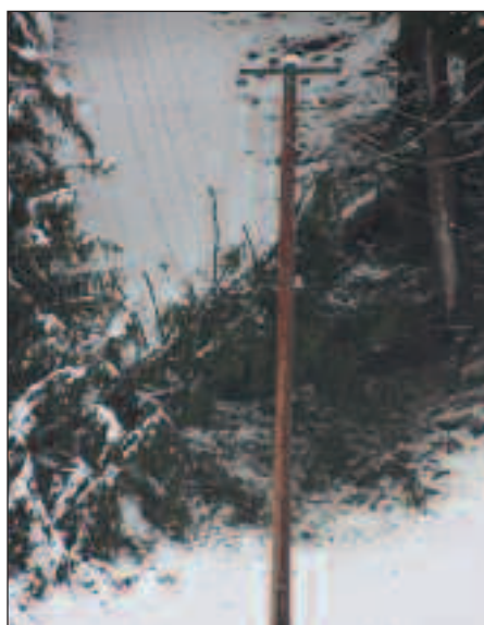
Schaden am TIWAG Netz und Stromausfall durch Schneedruck v. 28.11.2012 in Unterfelden
