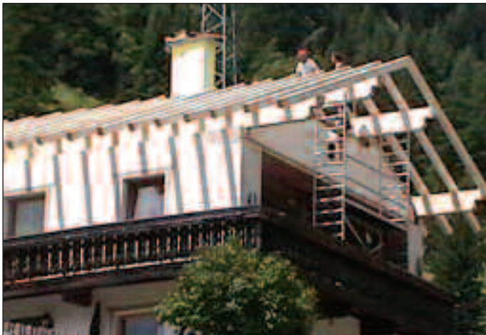
Erneuerung Dachstuhl inkl. Dämmung der letzten Decke Lusser Josef, HNr. 113
