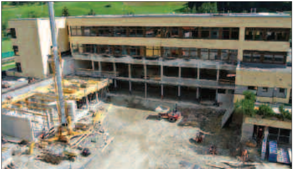
Baustelle Hauptschule im Sommer 2012
