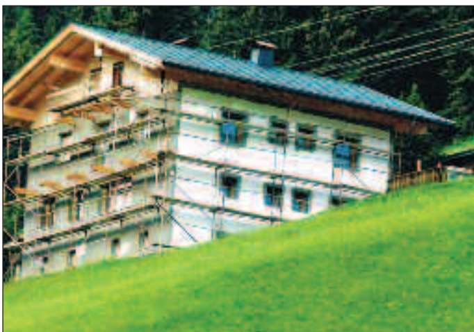
Erneuerung Dachstuhl, Vergrößerung Vordach Walder Franz, HNr. 25
