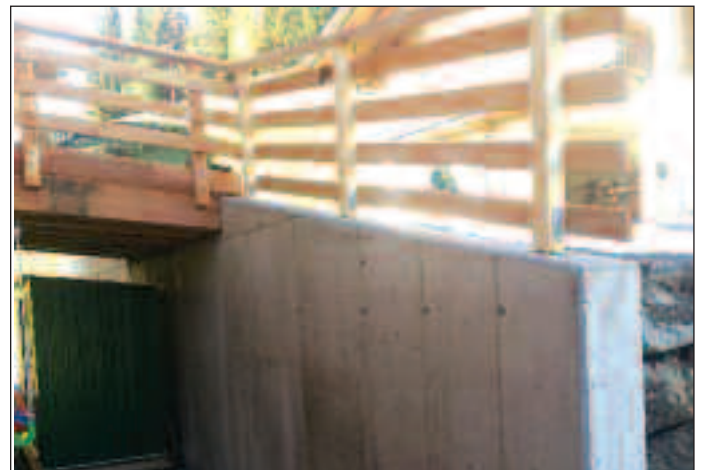
Errichtung einer Stützmauer Ortner Thomas, HNr. 72
