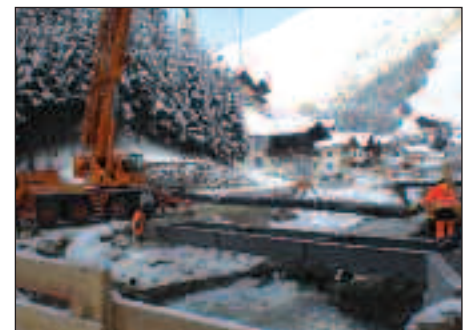
Baustelle Brücke Felseneheim
