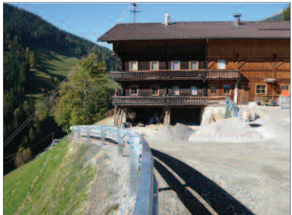
Neugestaltung der Hofzufahrt Weber mit privaten Umbauarbeiten an der Hofstelle
