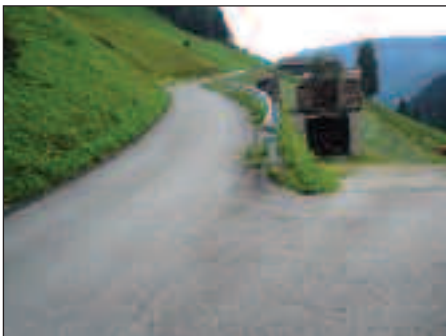
Unterperfl-Haine Furtschegg vor und nach dem Ausbau
