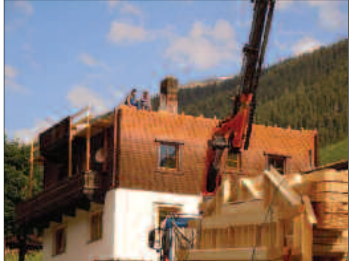
Zubau Lagerräume und Balkon, Neuerrichtung Dachkonstruktion Mühlmann Hubert, HNr. 52
