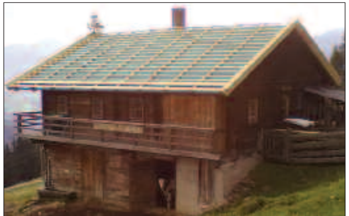
Dachsanieierung und Neueindeckung bei der bestehenden Almhütte Hofmann Michael, HNr. 16
