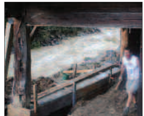
Renovierungsarbeiten an der Wurzersäge
